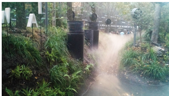
Figura 49 - Sistema de umidificação do ambiente. Expo 2015, outubro de 2015
