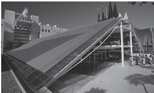
Figura 6 - Pavilhão da Áustria. Expo 1992, Sevilha.
