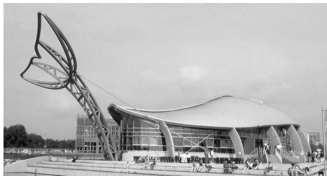
Figura 21 - Expo 2000, Hannover: Pavilhão da Esperança, Thomson Adsett Architects
