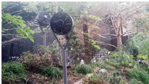
Figura 48 - Ventiladores umidificadores aéreos. Expo 2015, outubro de 2015
