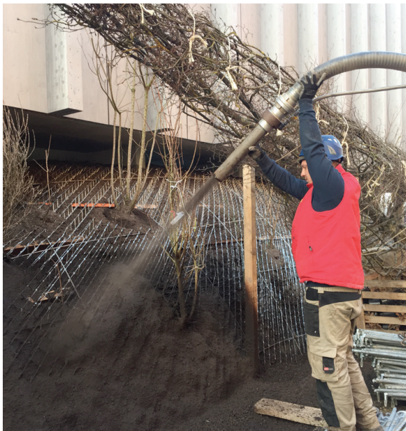
Figura 44 - Sistema de montagem da topografia com malha metálica
