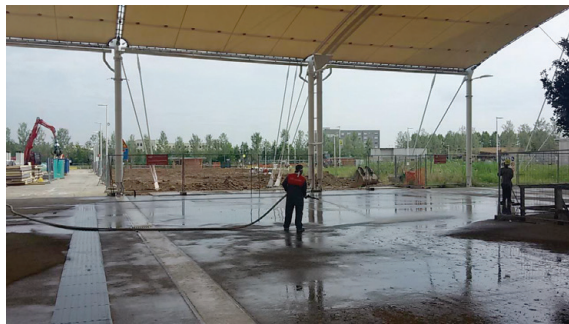
Figura 5 - Lote do Pavilhão do Brasil após demolição. Foto Marcelo Sávio
