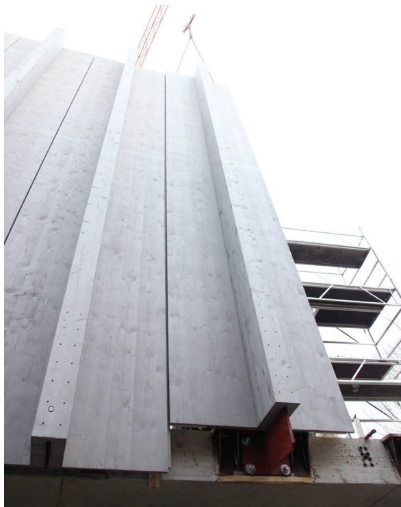
Figura 45 - Instalação dos painéis CLT
