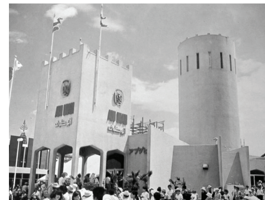
Figura 11 - Pavilhão de Abu Dabi na Expo Osaka, 1970, Osaka
