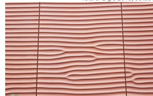
Figura 40 - Placas de GFRC imitando textura do vento na areia. Expo Milão. Outubro de 2015
