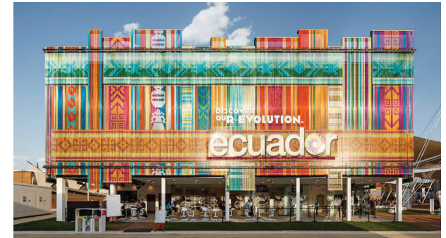
Figura 46 - Pavilhão do Equador. Expo 2015
