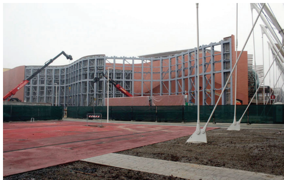
Figura 6 - Pavilhão do Emirados em desmontagem
