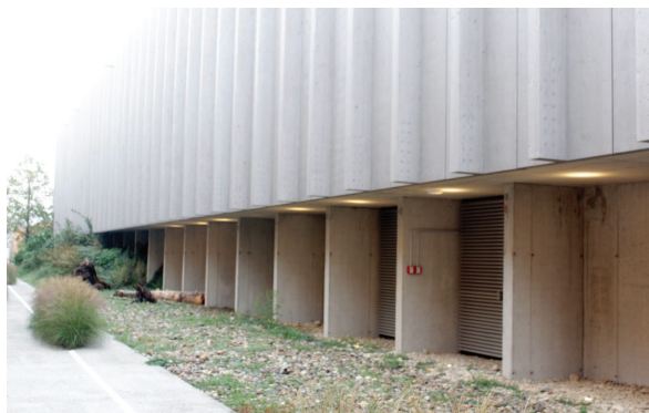
Figura 46 - Vista lateral . Pilares em concreto e vedação com painéis CLT
