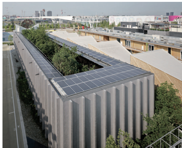
Figura 47 - Volume retangular contenedor da floresta. Vista dos painéis solares na cobertura. Foto de Marc Lins
