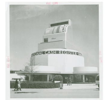
Figura 45 - Pavilhão do National Cash Register, Expo Nova Iorque, 1939
