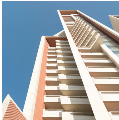
Figura 9 - Torres residenciais em Al Reem Island. Abu Dabi
