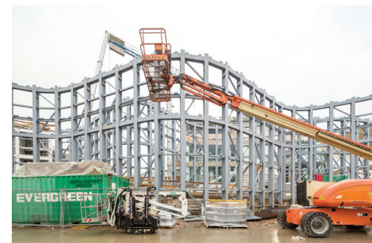
Figura 46 - Montagem estrutura das paredes curvas
