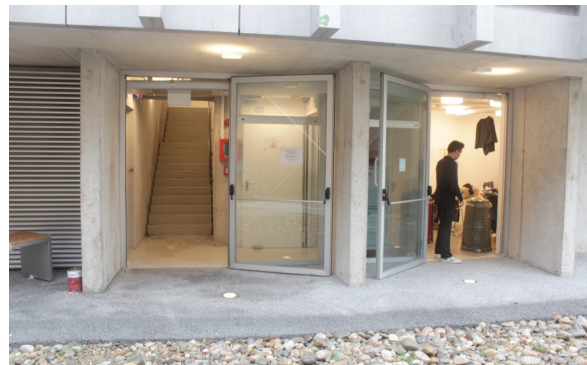
Figura 28 - Acessos de serviço pela parte externa do pavilhão, outubro de 2015
