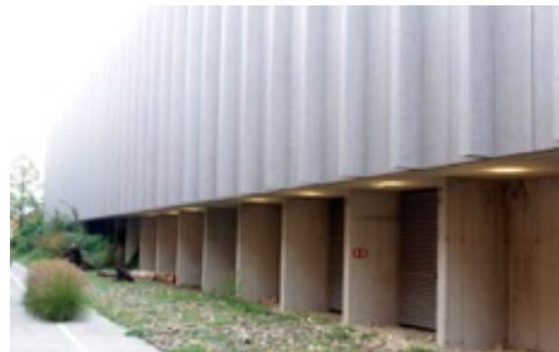
Fig. 18 - Estrutura em concreto e vedação e painéis de madeira "CLT". Foto da autora.
