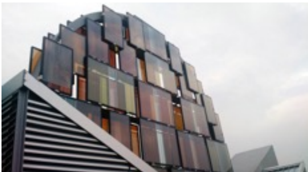
Fig. 15 - Escultura feita com placas de Graetzel cell no alto do pavilhão. Foto da autora.
