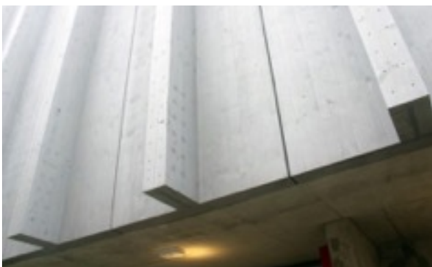
Fig. 17 - Detalhe dos painéis de madeira "CLT". Foto da autora.
